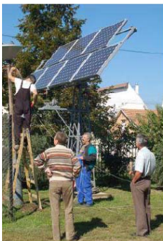
7 db KS 180 típusú monokristályos napelemeknek a felszerelése
