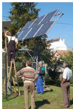
Montarea a 7 buc panouri solare mono-cristaline tip KS 180
