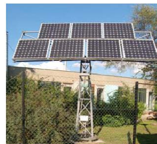
Montarea a 7 buc panouri solare mono-cristaline tip KS 180
