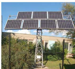
7 db KS 180 típusú monokristályos napelemeknek a felszerelése
